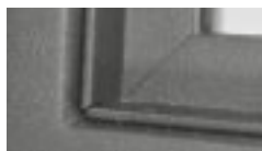
přiznaná spára - profil L
